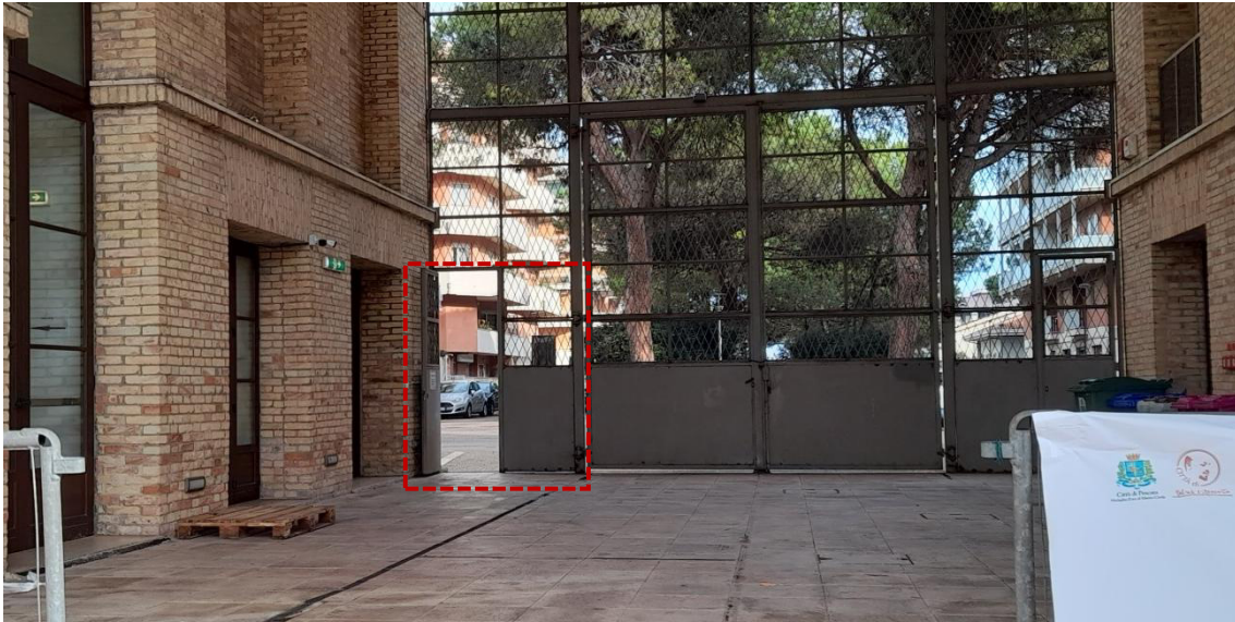
Accesso pedonale all'Istituto, via Cesare De Titta. A sx, l'ingresso costituito da unica anta apribile
